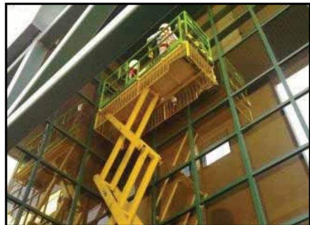
**Piattaforme di lavoro atte a ricevere attrezzature per un lavoro specifico, installato su proprio carro di base, aventi la possibilità di essere variate in quota rispetto a quella di riposo per l'intervento di apparecchiature di manovra comunque azionate e senza necessità di ancoraggi a struttura esterna.**
