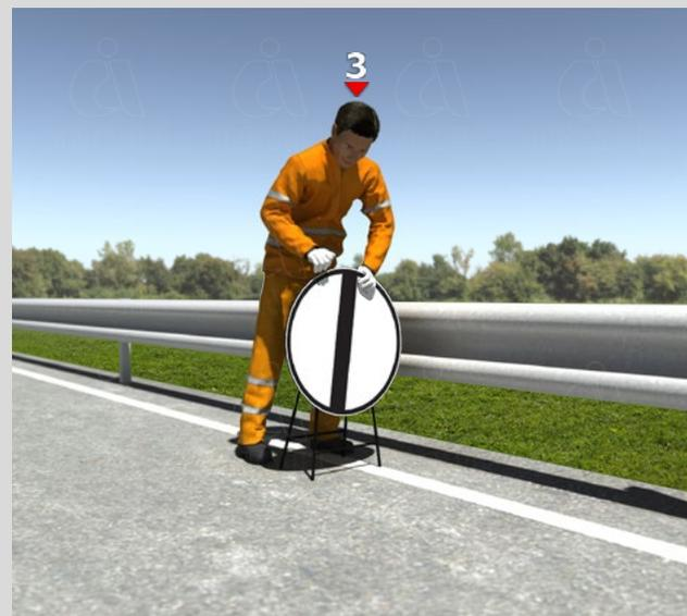
L'operaio 3 posiziona il segnale di VIA LIBERA (fig. II 70) sulla corsia interessata dai lavori. Attraversa la strada e posiziona il segnale di VIA LIBERA (fig. II 70) sulla corsia opposta a quella interessata dai lavori.
