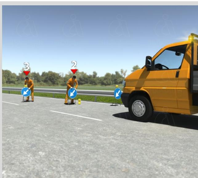
Protetti da mezzo, L'operaio 2 e l'operaio 3 posizionano i segnali di testata di cantiere (PASSAGGIO OBBLIGATORIO A DESTRA, ecc.).
