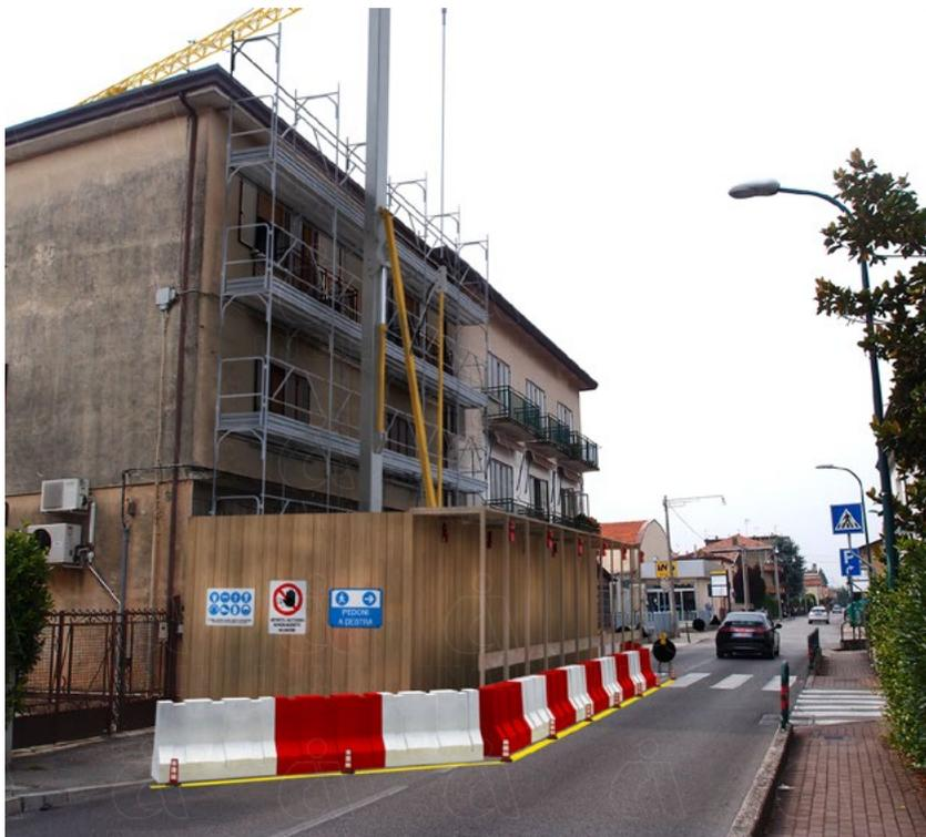
La delimitazione del cantiere verrà segnalata con luci rosse fisse (a bassa tensione) intervallati lungo il perimetro interessato dalla circolazione in modo che almeno tre luci ricadano sempre nel cono visivo del conducente.
