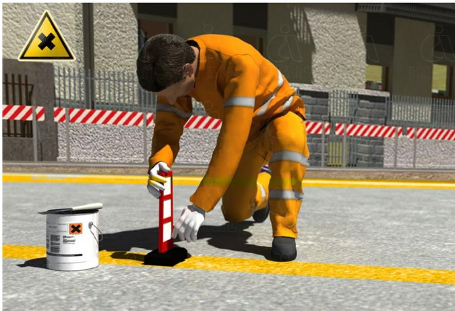
Durante l'uso delle materie prime contenenti agenti chimici è obbligatorio utilizzare i DPI specifici per i rischi chimici: occhiali, indumenti protettivi, guanti e maschera monouso per la protezione delle vie respiratorie.
