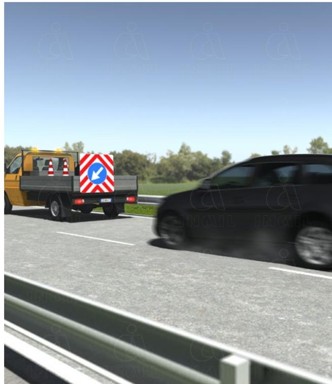
Nella posa della segnaletica se non è possibile installare tutti i segnali in una sola operazione, questi saranno prima depositati di piatto sulla banchina o sullo spartitraffico in corrispondenza del punto di installazione, successivamente rialzati una volta terminato l'approvvigionamento.
