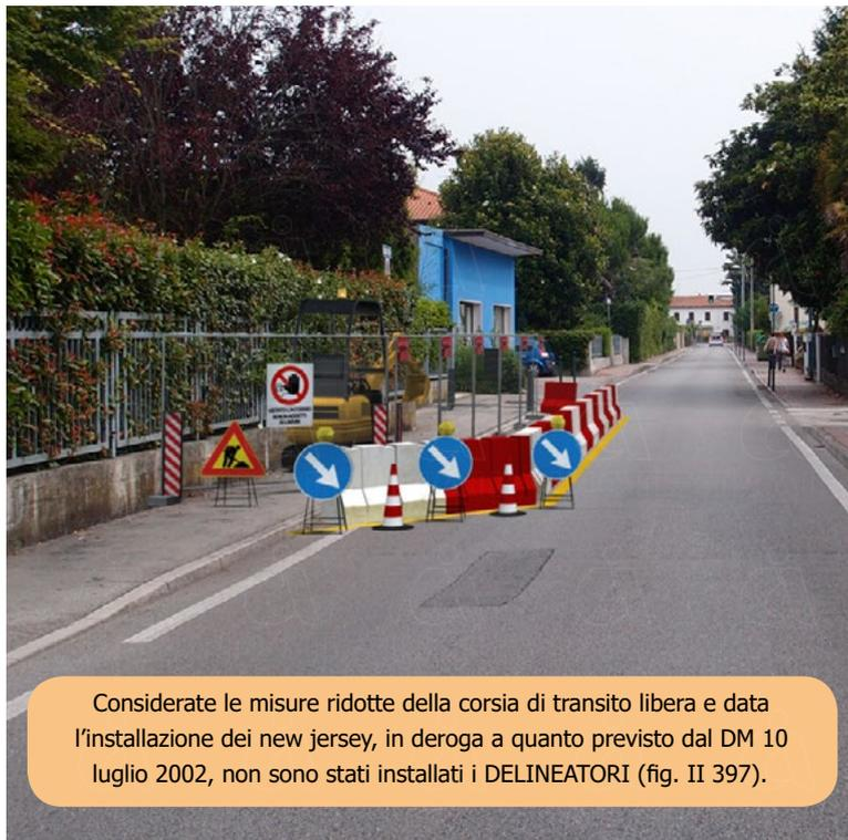
Considerate le misure ridotte della corsia di transito libera e data l'installazione dei new jersey, in deroga a quanto previsto dal DM 10 luglio 2002, non sono stati installati i DELINEATORI (fig. II 397).
