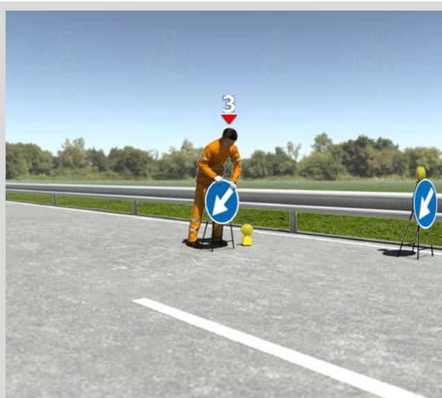
L'operaio 3 posiziona i segnali di deviazione di testata del cantiere (PASSAGGIO OBBLIGATORIO A DESTRA, ecc.).
