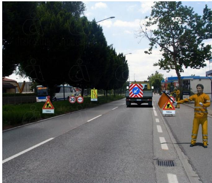
Il primo esempio illustra il metodo e la sequenza delle azioni che devono essere adottate per la posa della segnaletica in strade con larghezze tali che anche in presenza di uno o più veicoli operativi lo spazio risultante della corsia libera NON permette il passaggio in sicurezza di due veicoli che procedono in modo opposto tra loro.
