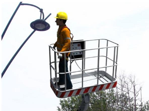
L'operatore nella cesta deve utilizzare la cintura di sicurezza collegata con una fune e moschettoni al punto di ancoraggio appositamente predisposto dal costruttore della piattaforma. La cintura va utilizzata in funzione di caduta trattenuta.
