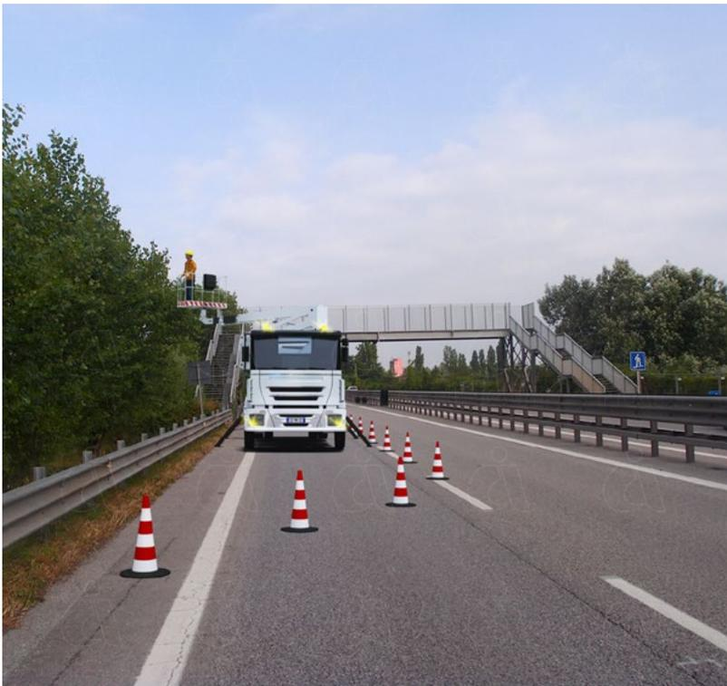
L'operatore nella cesta deve utilizzare la cintura di sicurezza collegata con una fune e moschettoni al punto di ancoraggio appositamente predisposto dal costruttore della piattaforma. La cintura va utilizzata in funzione di caduta trattenuta.
