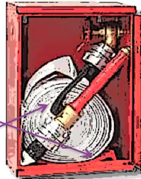
Un idrante a muro DN 45 deve normalmente assicurare, come prestazioni idrauliche minime, una portata non inferiore a 120 l/min, con una pressione residua non inferiore a 2 bar.
